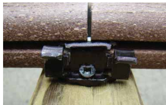
B. Colocación del clip entre dos topos de lama
