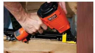
Opcional: Instalación con pistola Para clips simples o dobles
