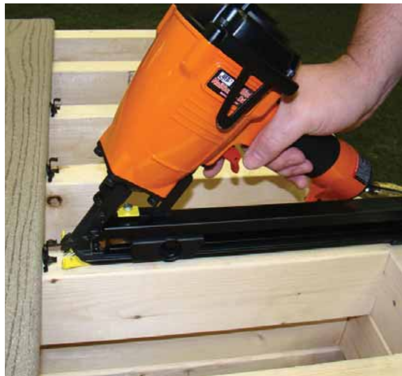
Clip simple para sujetar una sola lama al rastrel
